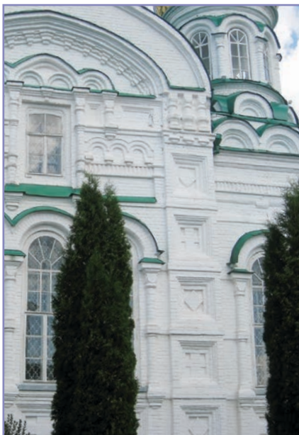
Крест - в узорной кладке Троицкого собора
